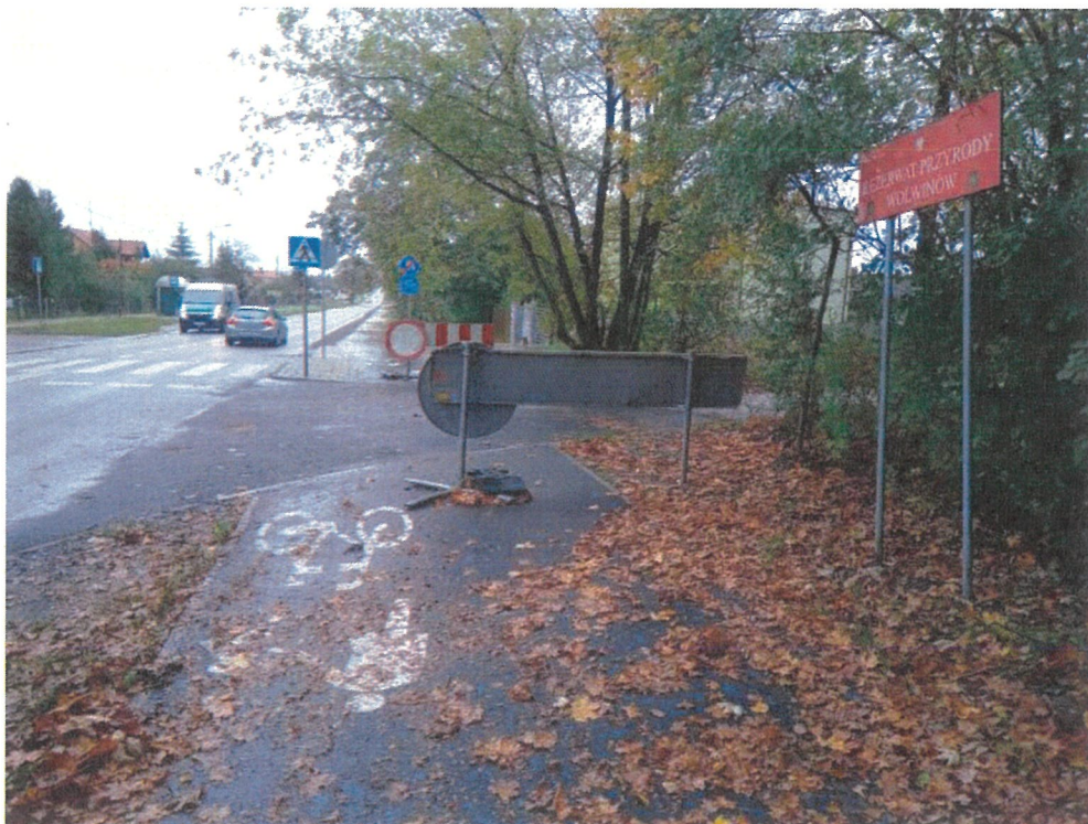
Brak oznakowania poziomego oraz pionowego.
