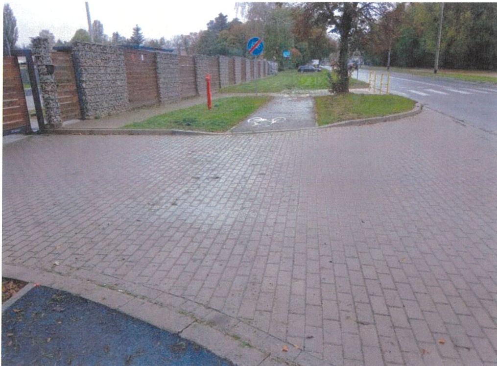
Wysokie krawężniki po obu stronach i brak przejazdu rowerowego oraz znaków poziomych P-11
